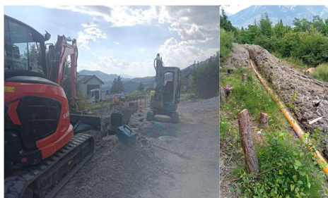
Renouvellement de réseau chemin de l'Amitié (Embrun)
