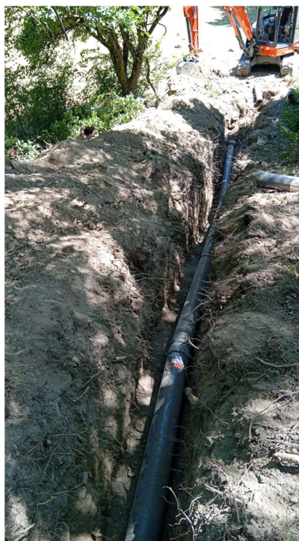
Renouvellement canalisation d'eaux usées Secteur « Caléryère » (Embrun)
