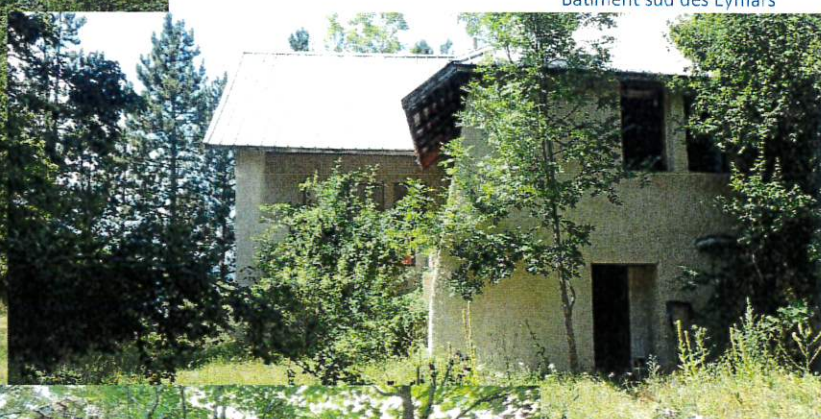
Bâtiment sud des Eymars
