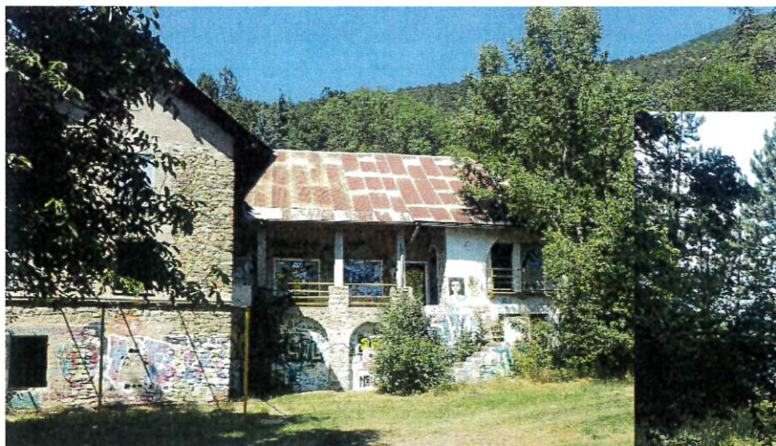
Bâtiment des Réaumes
