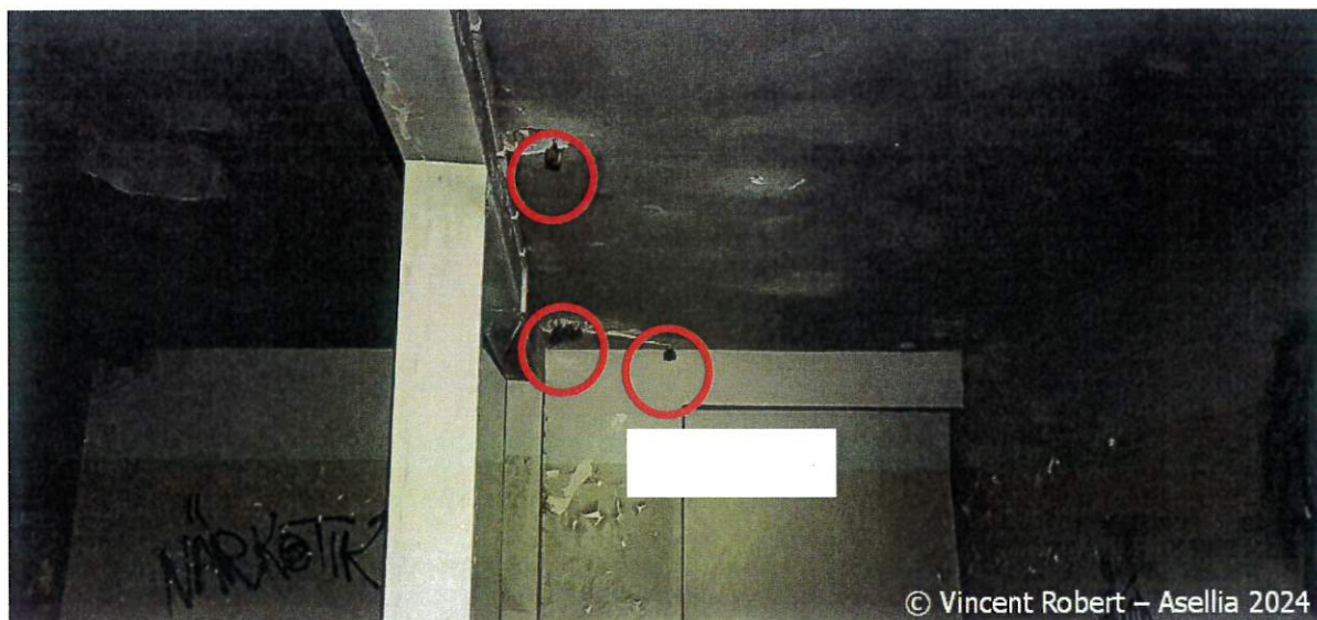
Bâtiment des Réaumes présentant une importante colonie de Petit rhinolophe dans les combles et les salles du premier étage.
