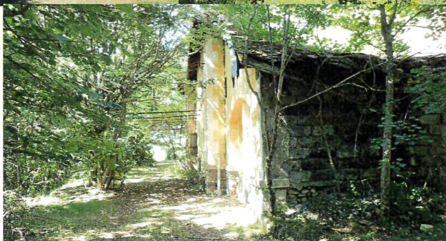
Bâtiment nord des Eymars
