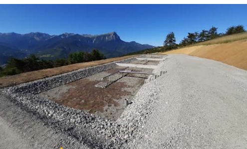
Station d'épuration Les Bouteils en travaux
